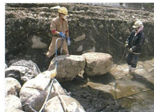
③ 発生材据付け
