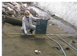
① 吸出し防止材の敷設
