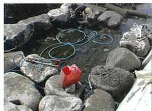
⑦ 外周部連結 1 (囲い枠製作)
