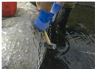
⑤ ラチェットU鋼を打ち込み (チェーンを通し掛けする)
