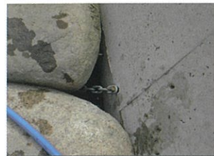
⑥ 根継コンクリートとの一体化 (現場によっては不要となります)
